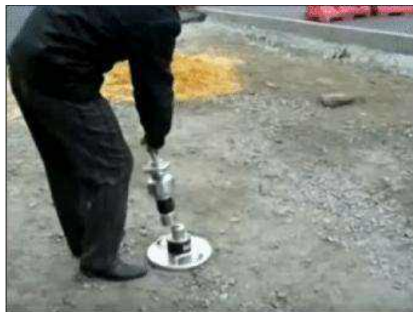
Рис.4.169. Установка нагружающего устройства в шаровую опору ПДН
