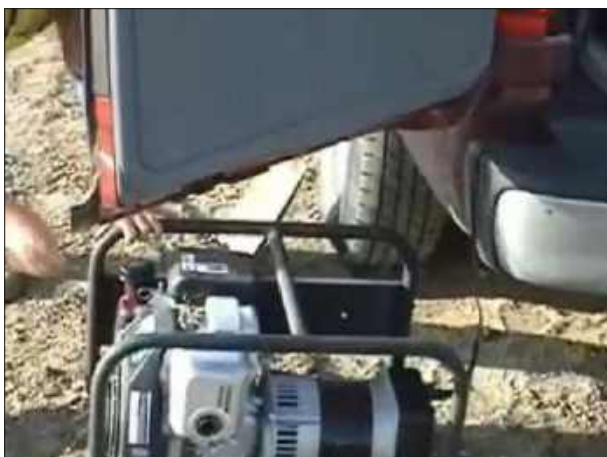
Рис. 4.131. Генератор, осуществляющий электропитание лаборатории
