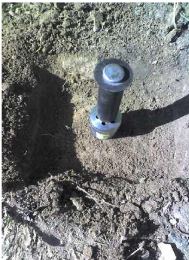
Рис.4.86. Погружение кольца в грунт на глубину 2 – 3 мм
