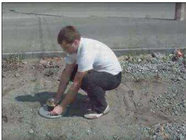
Рис.4.168. Установка ПДН на поверхность испытываемой конструкции
