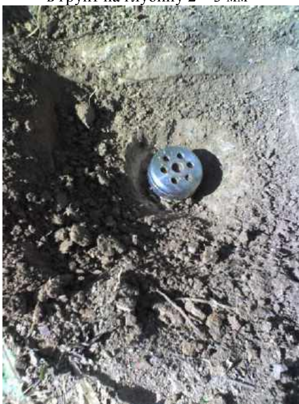
Рис. 4.88. Насаживание кольца на столбик
