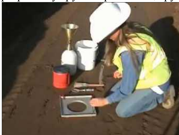
Рис. 4.117. Крепление листа основания на выровненной поверхности грунта
