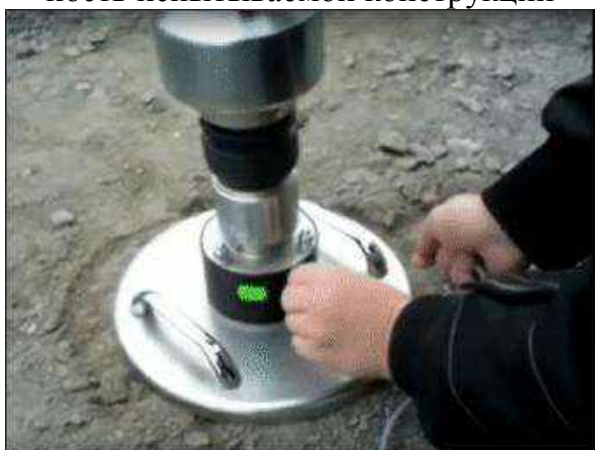
Рис.4.170. Подключение кабеля к ПДН
